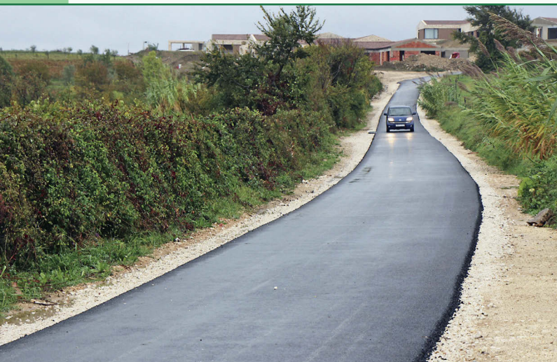
▼ Obnovljena cesta do Grobica
