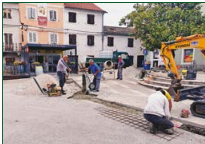
Radovi na trgu Mazzini
