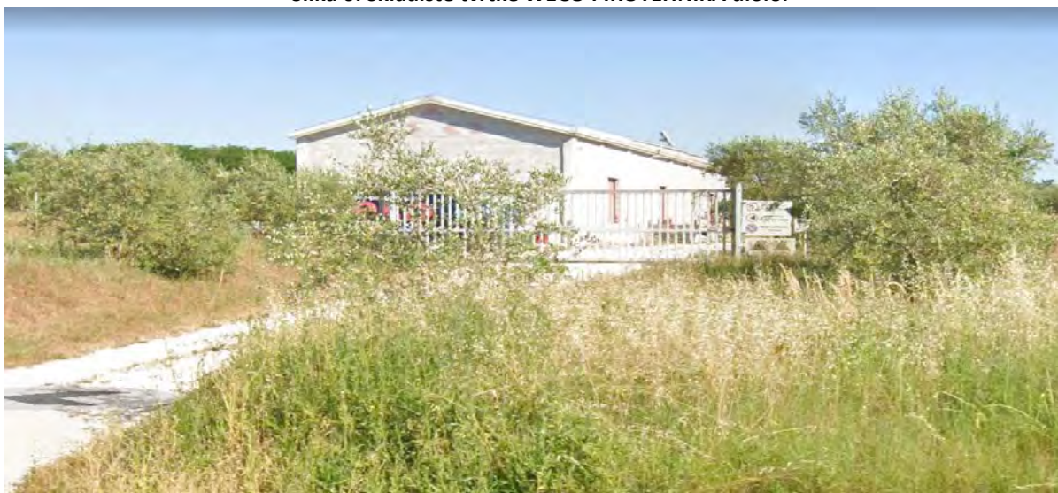
Slika 6: Skladište tvrtke WECO PIROTEHNIKA d.o.o.
