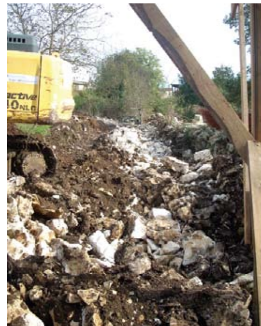
Iskop za kanalizacijski kolektor u Novoj Vasi
