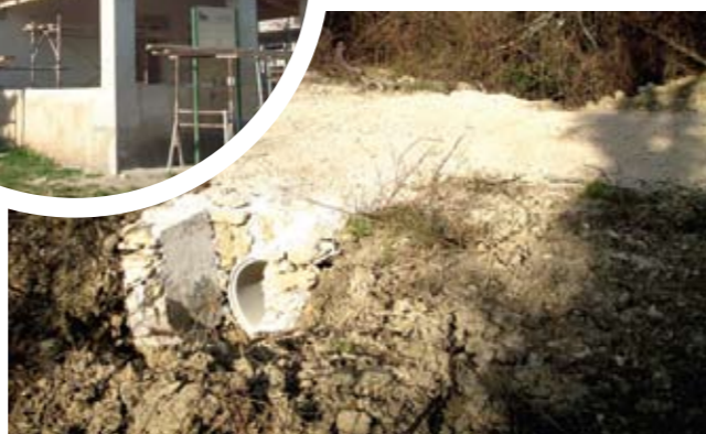
Uređenje oborinske odvodnje na cesti Brtonigla - Škrline
