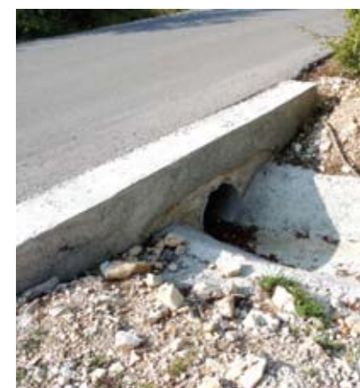
Betonski rigol -Serbani
