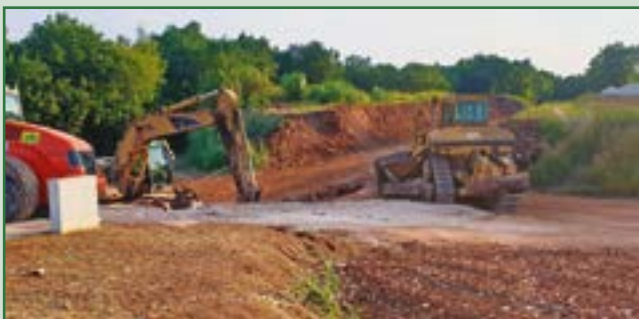
Gradnja prometnice kroz poduzetničku zonu Štrpe
