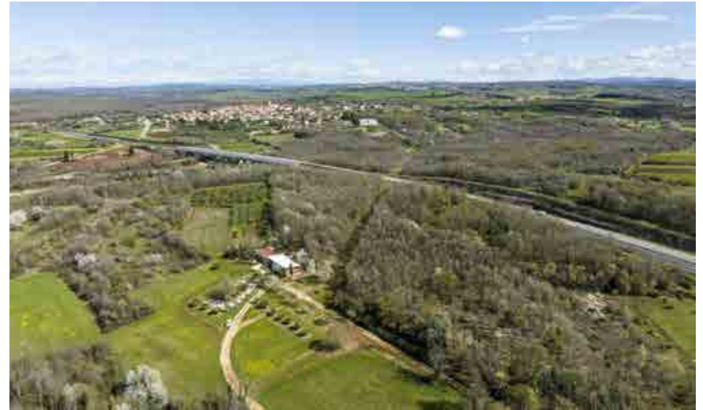
Sl. 6. Brežuljkasta zona u unutrašnjosti Općine Brtonigle–Verteneglio
