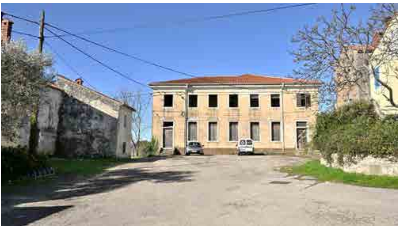
Sl. 54. Stara zgrada škole za obnovu u Novoj Vasi i asfaltirana površina koju se planira pretvoriti u ozelenjeni trg
