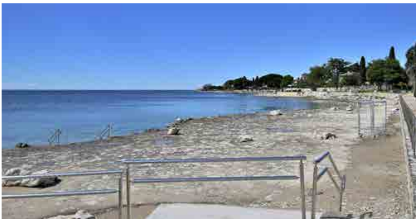
Sl. 82. U potpunosti betonirana obala u Karigadoru
