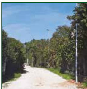
▼ Nastavlja se modernizacija javne rasvjete
